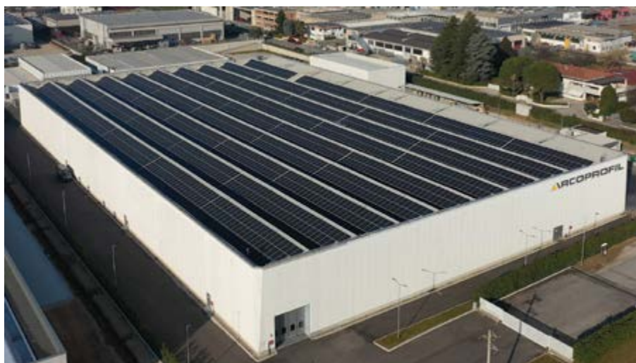
Arcoprofil può contare su un impianto fotovoltaico da circa 1.400 kW, che alimenta l'impianto IFP e copre una quota rilevante dei consumi
